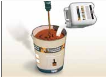
Per la preparazione si raccomanda di utilizzare un miscelatore elettrico
